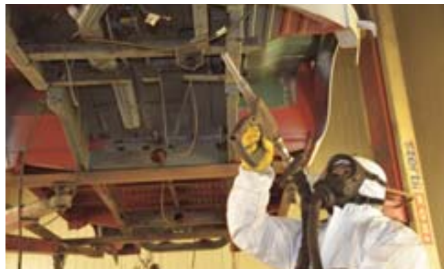
Trockeneisstrahlen eignet sich zum Entlacken sowie zum sorgfältigen Reinigen - und ist damit ein ideales Verfahren zur Bestandsaufnahme.
